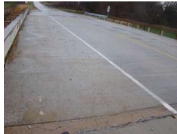
(d) Epoxy with Embedded Grit
